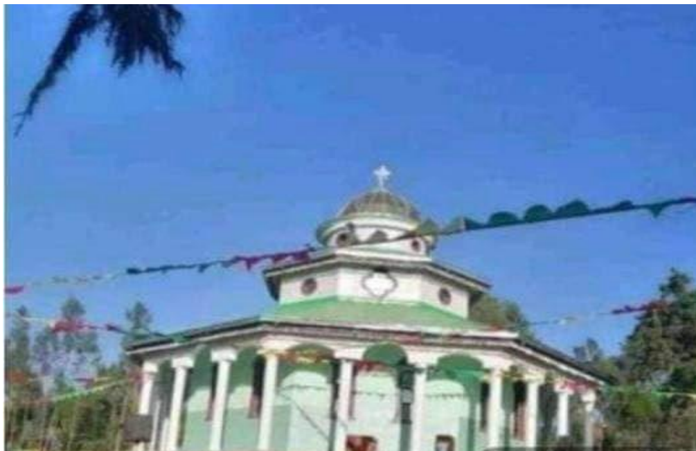
ሰዕል 9፡ የቂልጦ ፍኖተ ሎዛ ቅድስት ድንግል ማርያም ቤተክርስቲያን ገዳም
